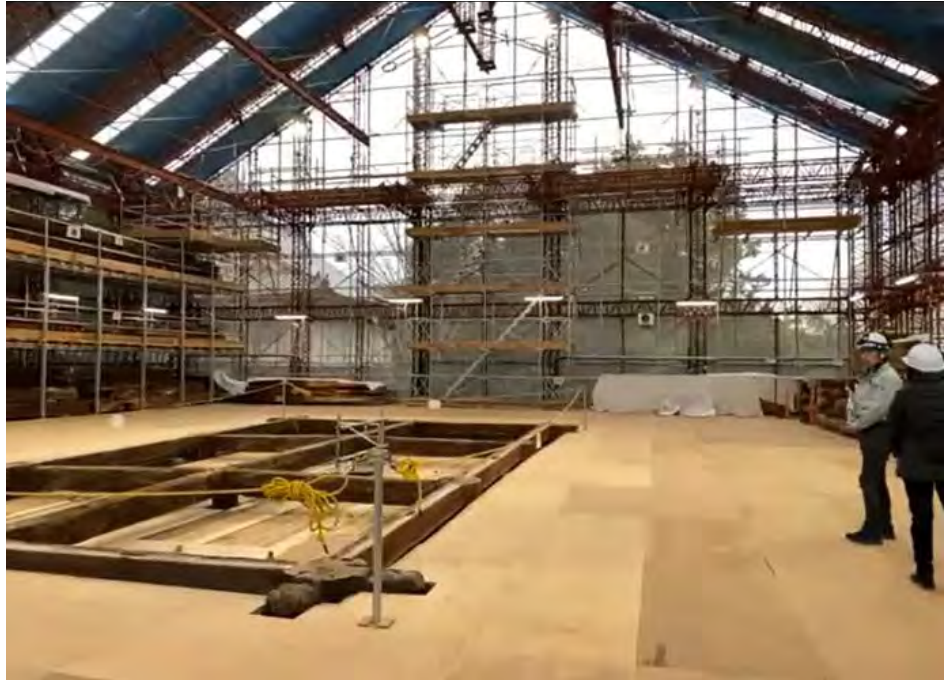
사진 7: 해체가 끝난 이층 지붕
