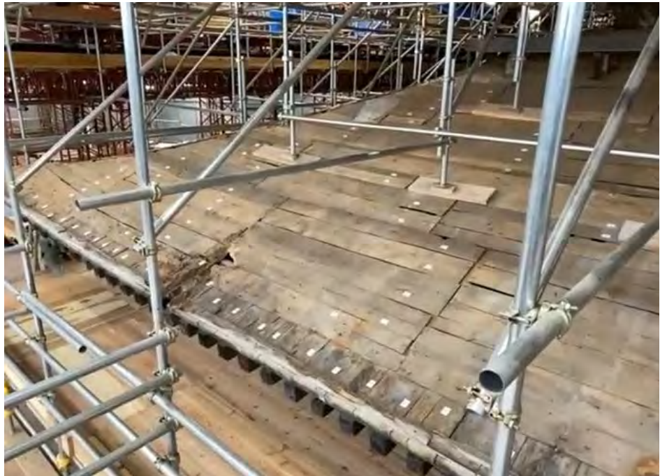
照片 6 : 下层的屋顶
